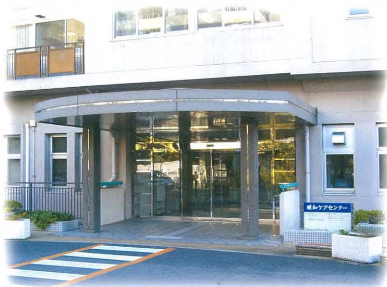
緩和ケア病棟正面出入口の外観風景
